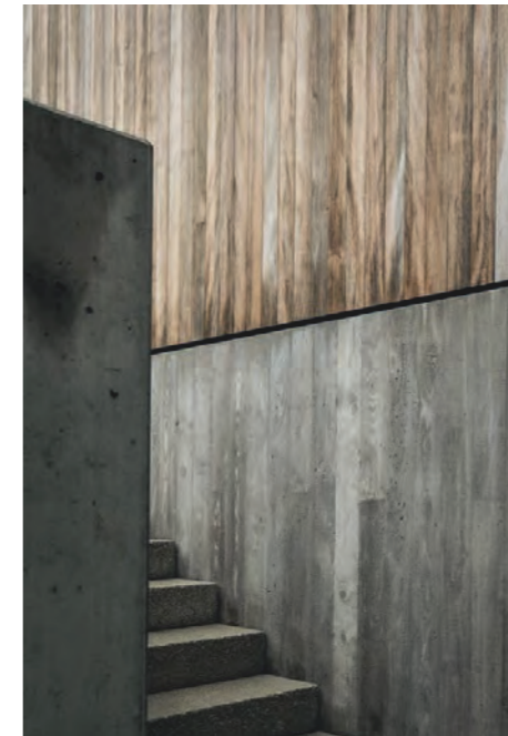
Træ og Beton med forskalling
