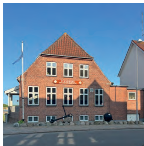
Den røde gavl mod gaden Færgevej 5
